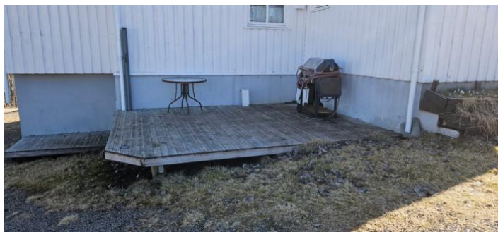
Markplattning mot nordvest
