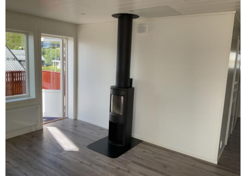
Vedovn med isolert stålpipen i loftstua.
