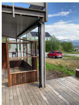
Takrenne og taknedløp under balkong mot sør.
