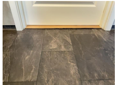
Ventilasjonsspalte i underkant av døra.
