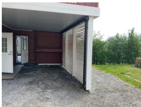
Overbygget inngangsparti på 23 m2.
