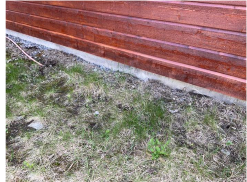
Drenering fra byggeåret.
