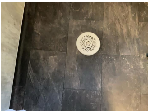
Plastsluk med plastlokk.
