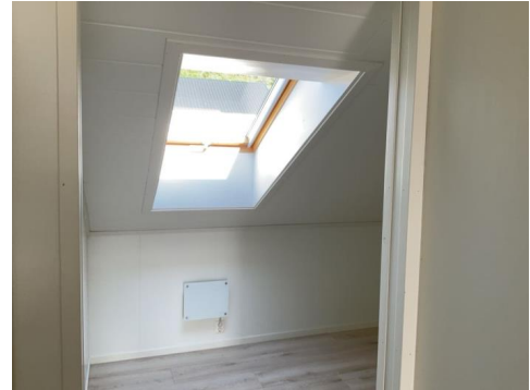
Takvindu i et soverom.
