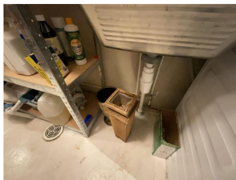
Vanntilførsel og avløp mot murvegg under skyllekar.
