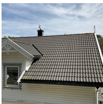
Taktekking med betongtakstein
