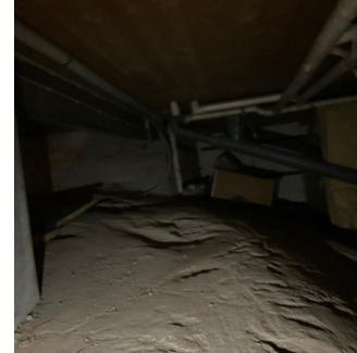
Fjellgrunn _ krypkjeller med varierende høyde
