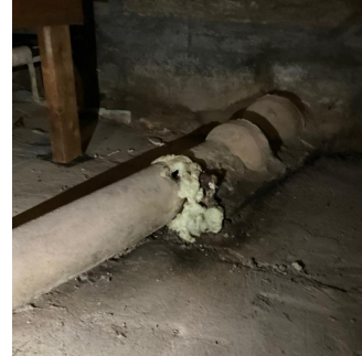
Støpejernrør i krypekjeller _ ukjent funksjon
