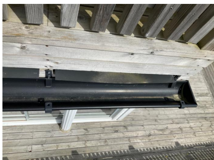
Plater under terrassebord ført ut ved takrenne _ tak over vinterhage _
