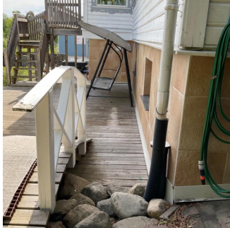
Isolert grunnmur / yttervegg med flislagt overflate, sokkelbeslag
