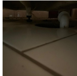
Sluk under dusjkabinett _ ikke tilgjengelig for undersøkelse ved befaring
