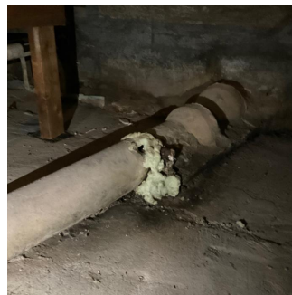
Støpt rør ved øvre del av krypekjeller _ ukjent funksjon
