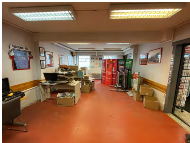
Vinylbelegg på betong. Lokalet ble benyttet som lager ved befarig
