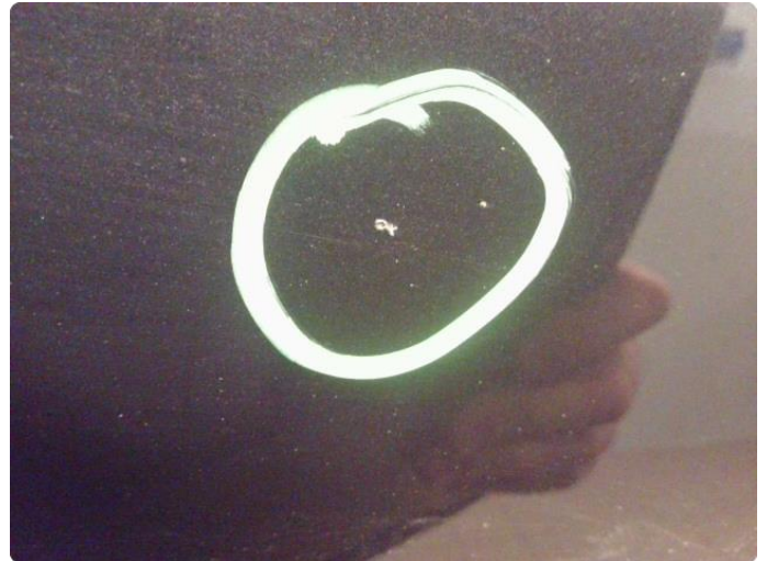
1.1 Steinsprut med rust
