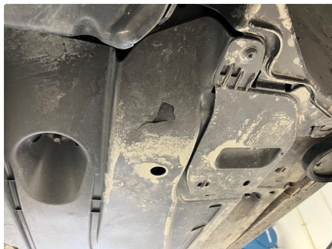
1.1 Sprekker i skliplate
