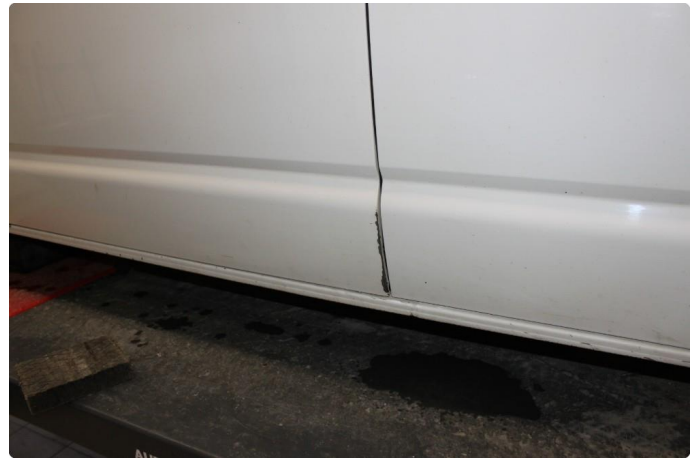
1.2 Rust på venstre skyvedør, flere plasser.
