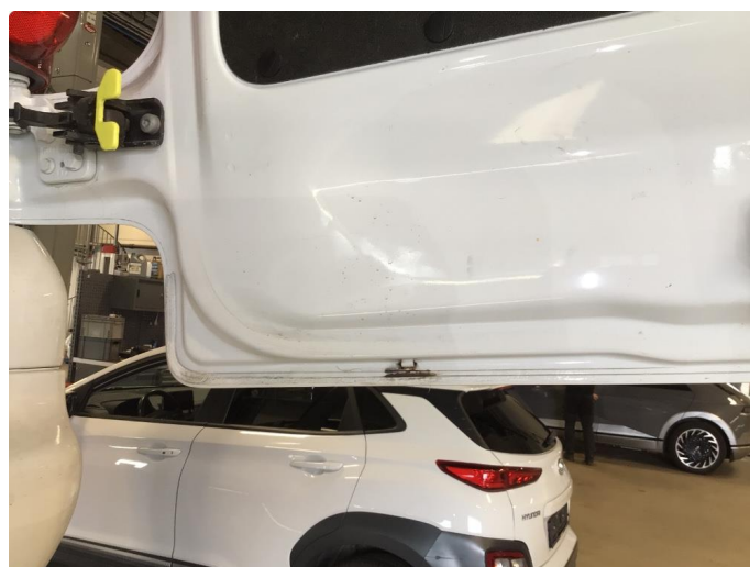
1.3 Rust i fals
