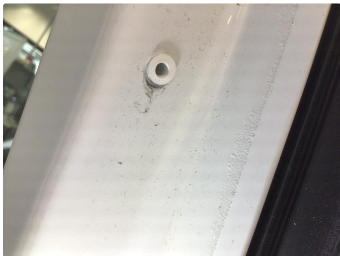
1.4 Rust i fals
