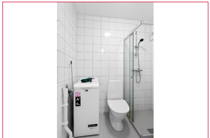
bad med opplegg til vaskesøyle
