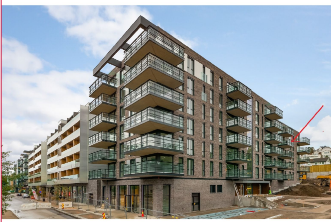
Leiligheten ligger fint til i 5.etg og har flott utsikt fra balkong!
