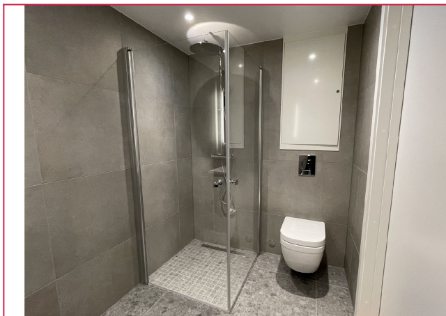
Flislagt bad med dusjhjørne og vegghengt toalett
