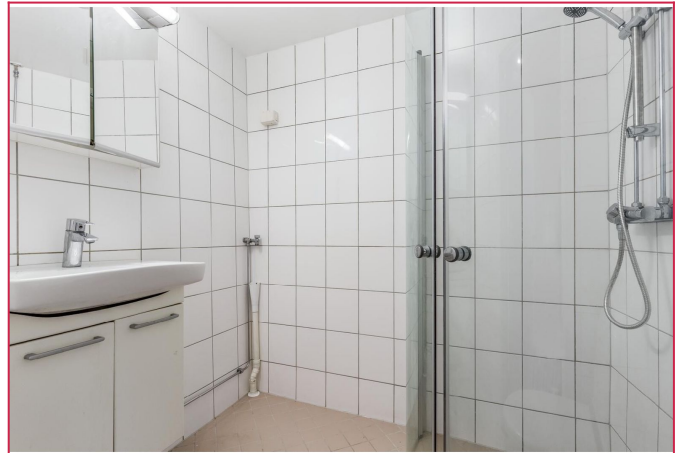
Flislagt bad med opplegg for vaskemaskin.
