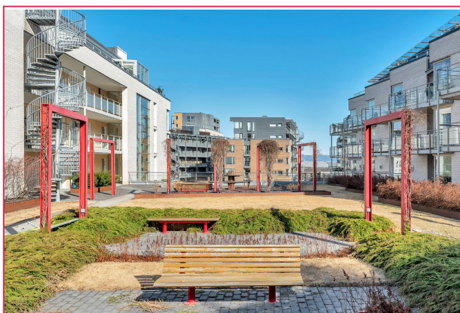
Felles takterrasse med hage
