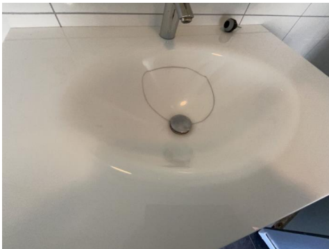
Sprekk i servant.
