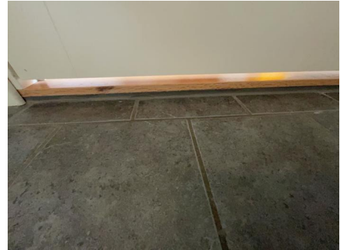
Spalte mellom dørblad og dørterskel.
