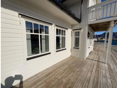
Utsnitt av vinduer.
