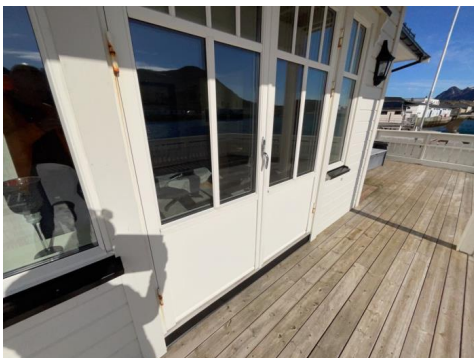
Verandadør - utgang fra stue.
