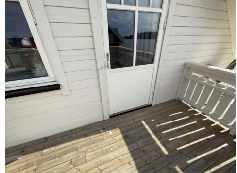
Verandadør på loftplan - utgang til takterrasse.
