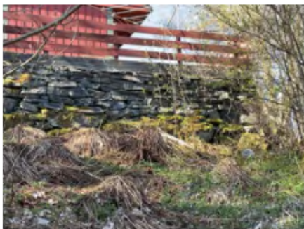
Forstøtningsmur i naturstein
