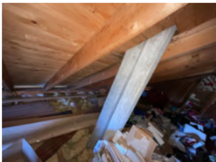
Ventilasjonskanaler av eternitt
