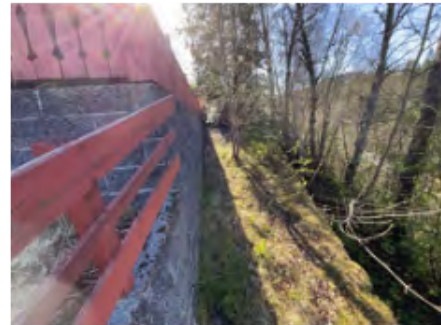
Forstøtningsmur i leca
