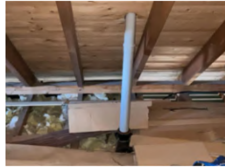
Lufting av avløpsrør over tak
