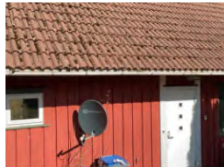
Takrenner er fra byggeåret.
