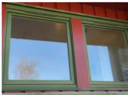
Vinduer er fra byggeåret
