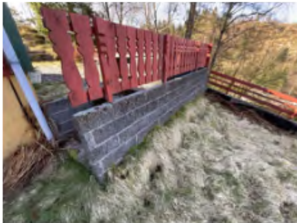
Forstøtningsmur i leca
