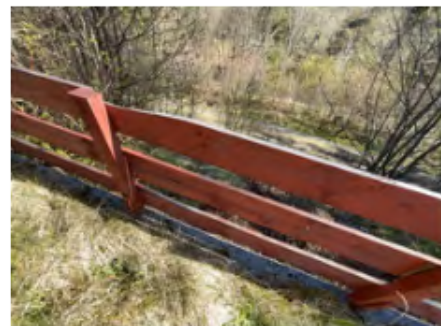
Forstøtningsmur i naturstein
