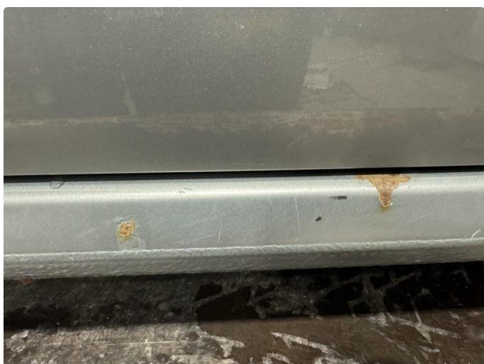
2.2 Tersklene har noe rust
