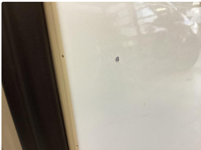
1.1 Bulk med lakkskade
