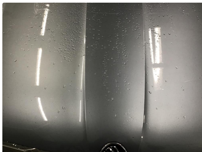
1.1 Steinsprut /Brukslitasje panser
