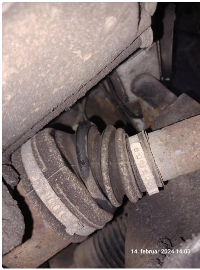
4.2 Svetting fra drivakselmansjett. Skiftet mars 2024
