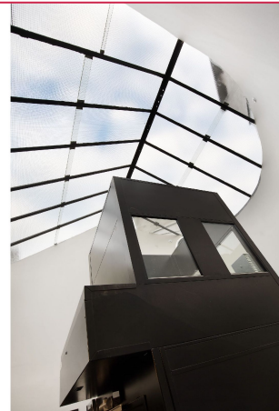
oppgang med heis
