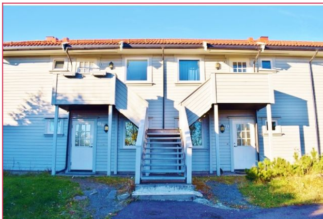
Fasade, leiligheten ligger i 2.etasje.
