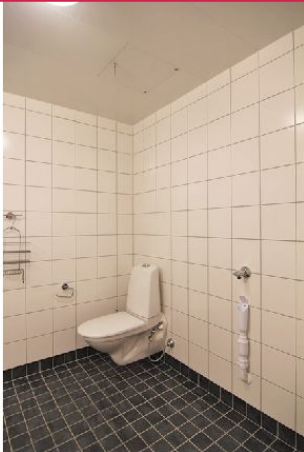
Flislagt bad med varmekabler, vegghengt toalett og opplegg til vaskemaskin.
