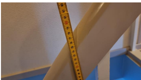
Høyde rekkverk ca 75 cm
