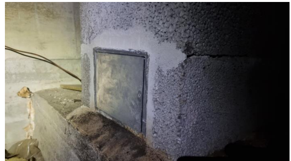
Pipe og sotluke i krypkjeller
