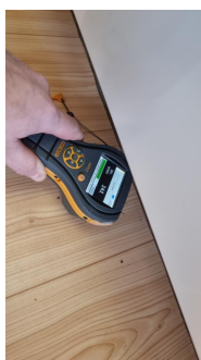
Fuktmåling under oppvaskmaskin - ingen høye verdier
