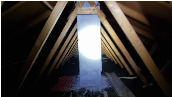
Pipe sett fra kaldloft
