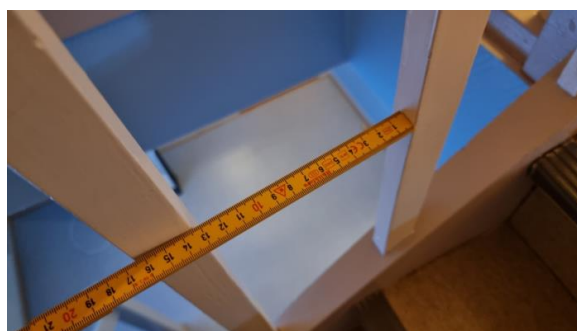
Avstand mellom spiler ca 13 cm
