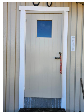
Dør til balkong har noe fuktskader og dårlig tetting nederst.
