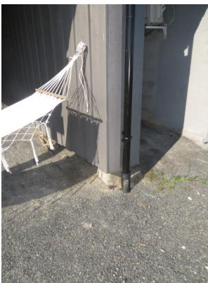
Del av fundamenter til terrasse.
