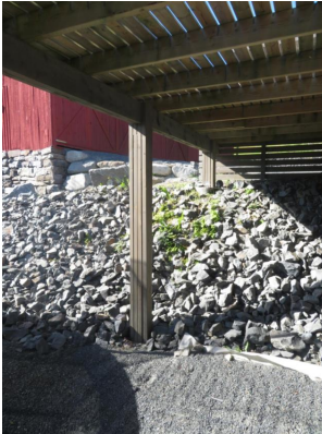
Del av fundamenter til terrasse.
