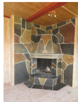
Murt gruepeis i u.etg - skiferforblendet.
