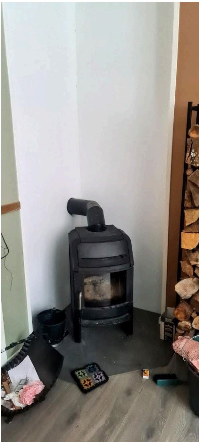
Jøtul F220 peisovn hvor avstand å siden er mindre enn 400mm som monterings beskrivelsen angir.
