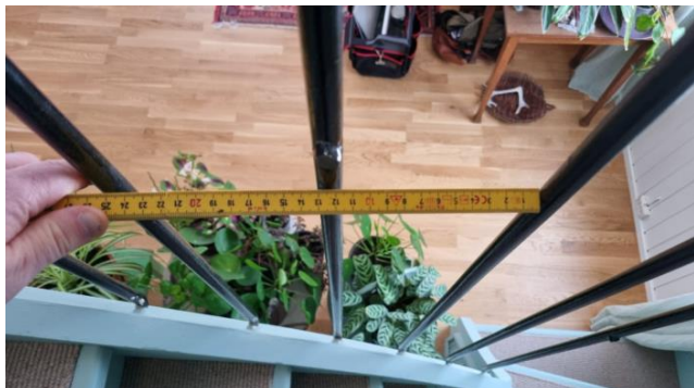
Kontroll av åpninger i rekkverk.
