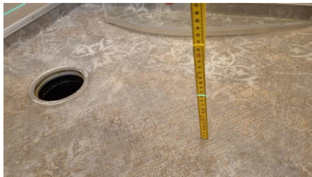
Kontroll av fall mot sluk.
