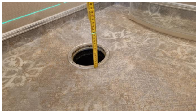
Kontroll av fall mot sluk.
