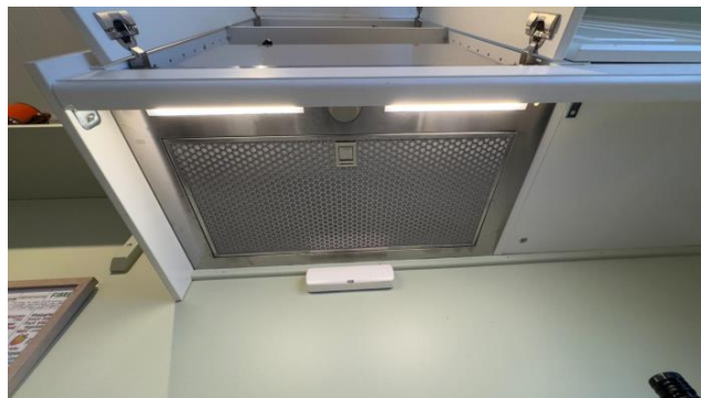
Kontroll av avtrekk.
