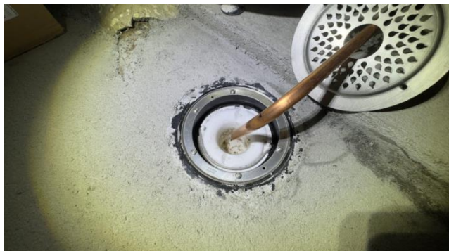
Kontroll av sluk.
