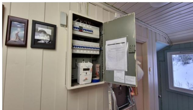
Kontroll av el-skap og kursfortegnelse.
