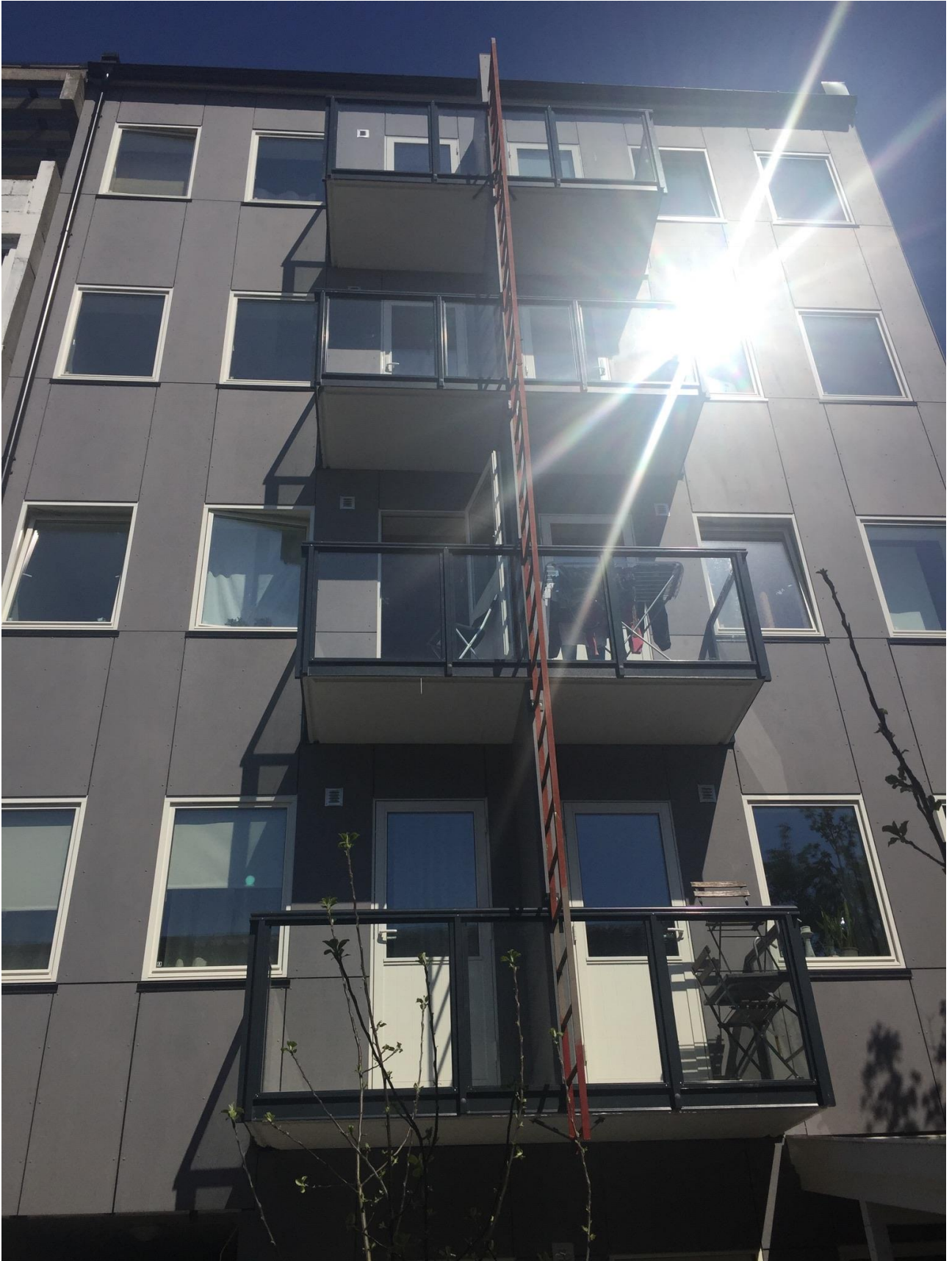
Leiligheten ligger høyt og luftig i 5. etasje med utsikt.
