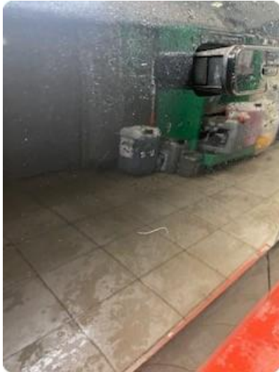
1.1 Ripe ned til grunning
