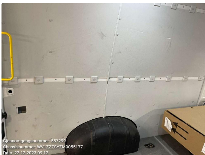
4.1 Kledning/gulv skadet. Blir ikke utbedret.
