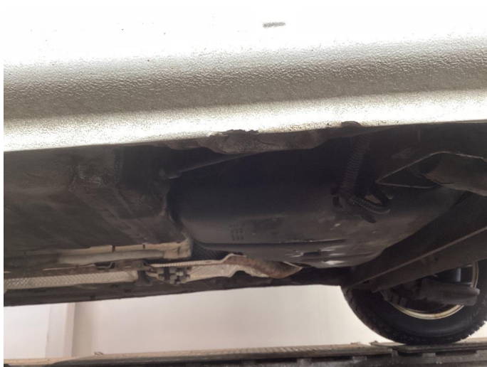
1.3 Noe merker i kanaler etter jekk
