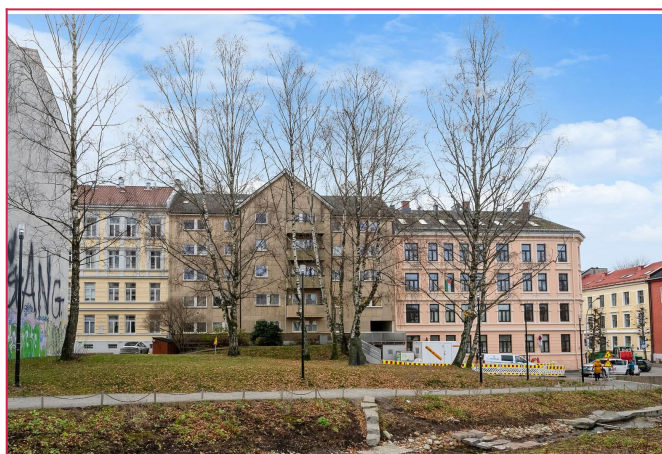
Fasade - Leiligheten ligger i 3. etasje
