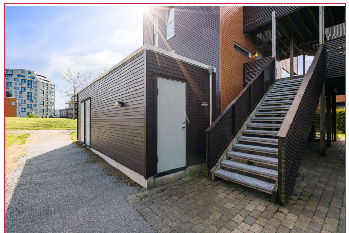
Inngangsparti og bod
