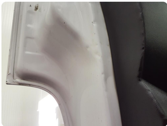
3.4 Flere bulker Tillegg rust , må kontrolleres
