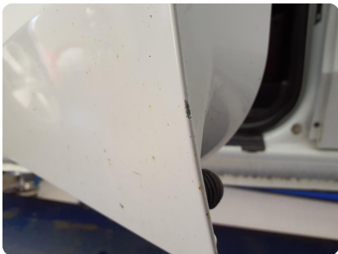
3.4 Flere bulker Tillegg rust , må kontrolleres
