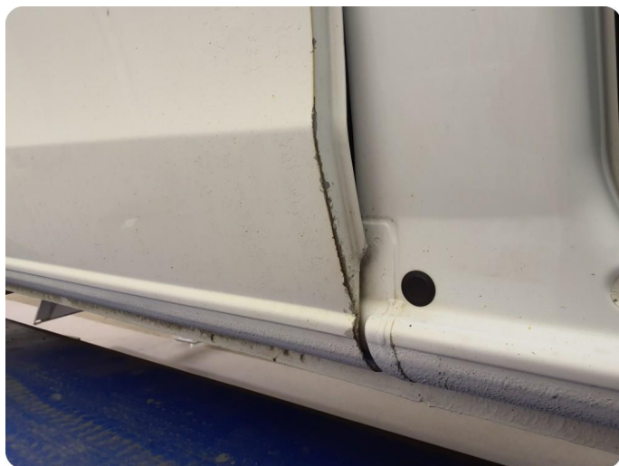
3.4 Flere bulker Tillegg rust , må kontrolleres
