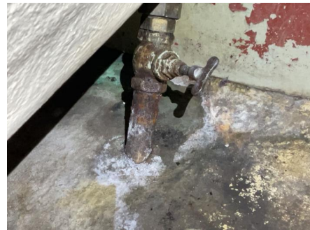
Vannrør elde anlegg fra byggeår.
