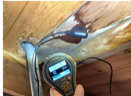
Fuktskjolder i taktro. Ved befaring måles det ingen unormale fuktverdier.
