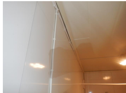
Innvendig vegg med buler- og svanker.
