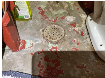
Elde jernsluk innstøpt i gulv.
