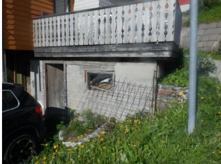
Terrasse oppført med impregnert dekke samt rekkverk furu malt utførelse.
