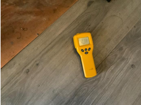
Målt fukt i gulv ved pipe
