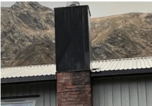
Utett pipebeslag. Det opplyses at det kommer vann inn i stua
