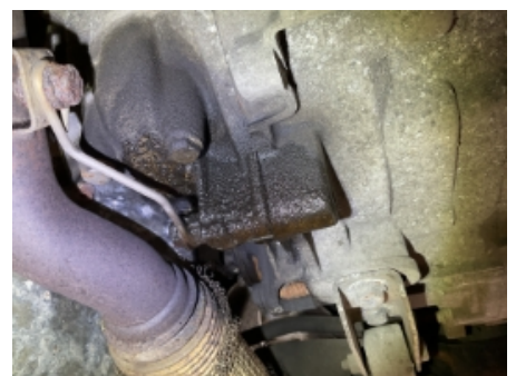
36. Utvendig tilstand motor
