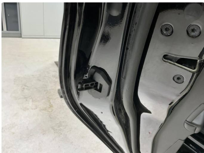
1.1 Mangler beskyttelseslist v.bakdør.
