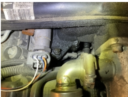
19. Utvendig tilstand motor
