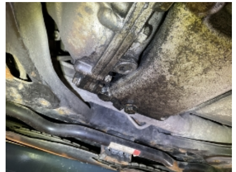
42. Utvendig tilstand motor
