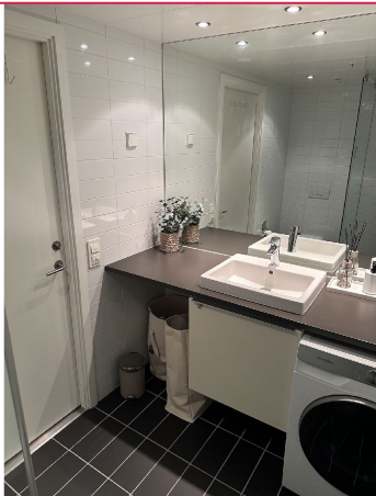
Gulvvarme og opplegg for vaskemaskin på badet.
