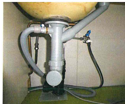
Ingen synlige lekkasjer eller fukt rundt rør under vask.
