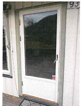
Terrassedør med utgang fra stue. Skiftet i 2006.
