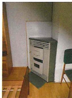
Bildet viser kombinert ved og parafin/olje brenner.
