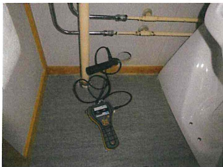
Bildet viser hulltaking, ingen unormale fuktverdier.
