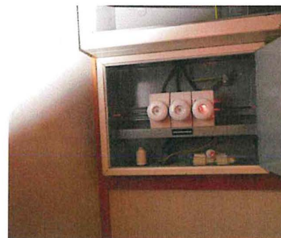
Bildet viser inntakssikringer fra byggeår.
