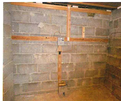
Bildet viser rom i kjeller med lettklinkerblokker.
