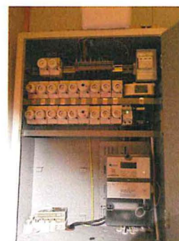
Bildet viser inntakssikringer fra byggeår.
