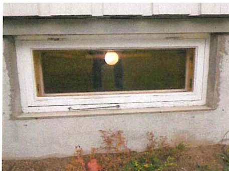
Bildet viser vindu som er i kjelleretasjen.
