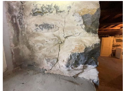
Sprekkdannelser i fuger
