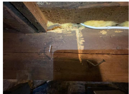
Det er registrert symptom etter aktivitet fra skadedyr
