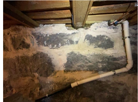
Sprekkdannelser i fuger
