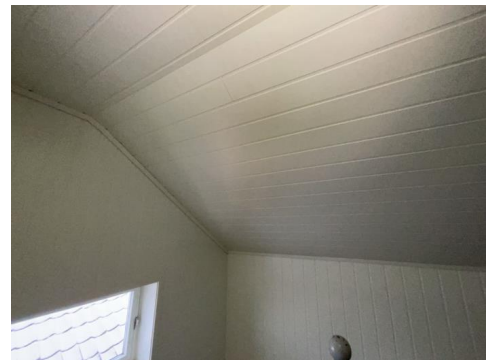
Mønt himling ( gjentettet innvendig tak)
