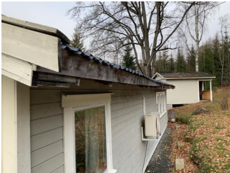
Det mangler en del forkantbord.
