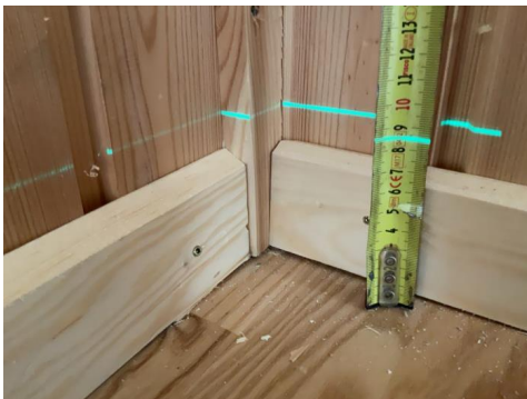
Høyde mot yttervegg ved kjøkken.
