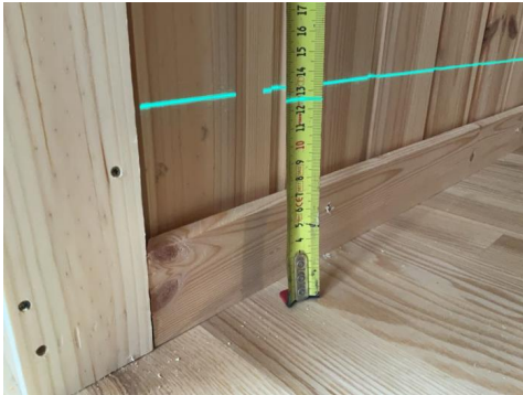
Høyde yttervegg mot vest.
