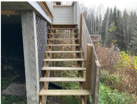
Trapp til terreng.
