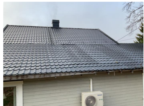
Bulker på takplater.
