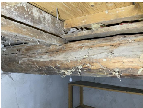
Tørråte i bjelker.
