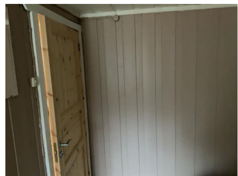
Pipe er kledd inn på ett soverom.
