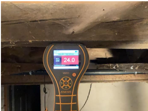
Fuktmåling i bjelker i kjeller.
