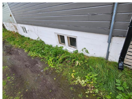
Oversiktsbilde over grunnmuren mot vest.
