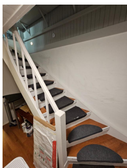
Hovedtrapp - Åpninger i rekkverk/skillekonstruksjon ble målt større enn 10 cm, både vertikalt og horisontalt.
