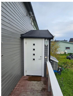
Gjenbygget takkonstruksjon over tilbygget.
