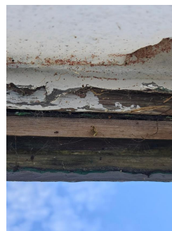
Underkant av bordkledning, mot grunnmur.
