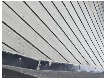
Overgangsbeslag mellom tilbygget og hovedbygget er lagt opp mot bordkledningen.
