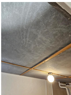
Eternittplater på innvendig tak i vaskerom.
