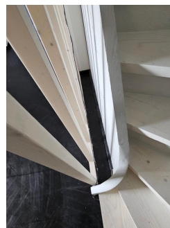
Hovedtrapp - Nær bilde av åpninger større enn 10 cm.
