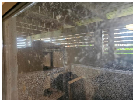
Terrengoverflaten synes å være flat under veranda.
