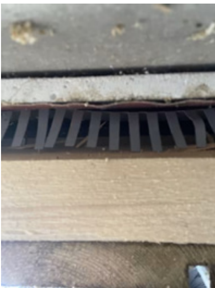
Lufting og musetetting bak kledning.
