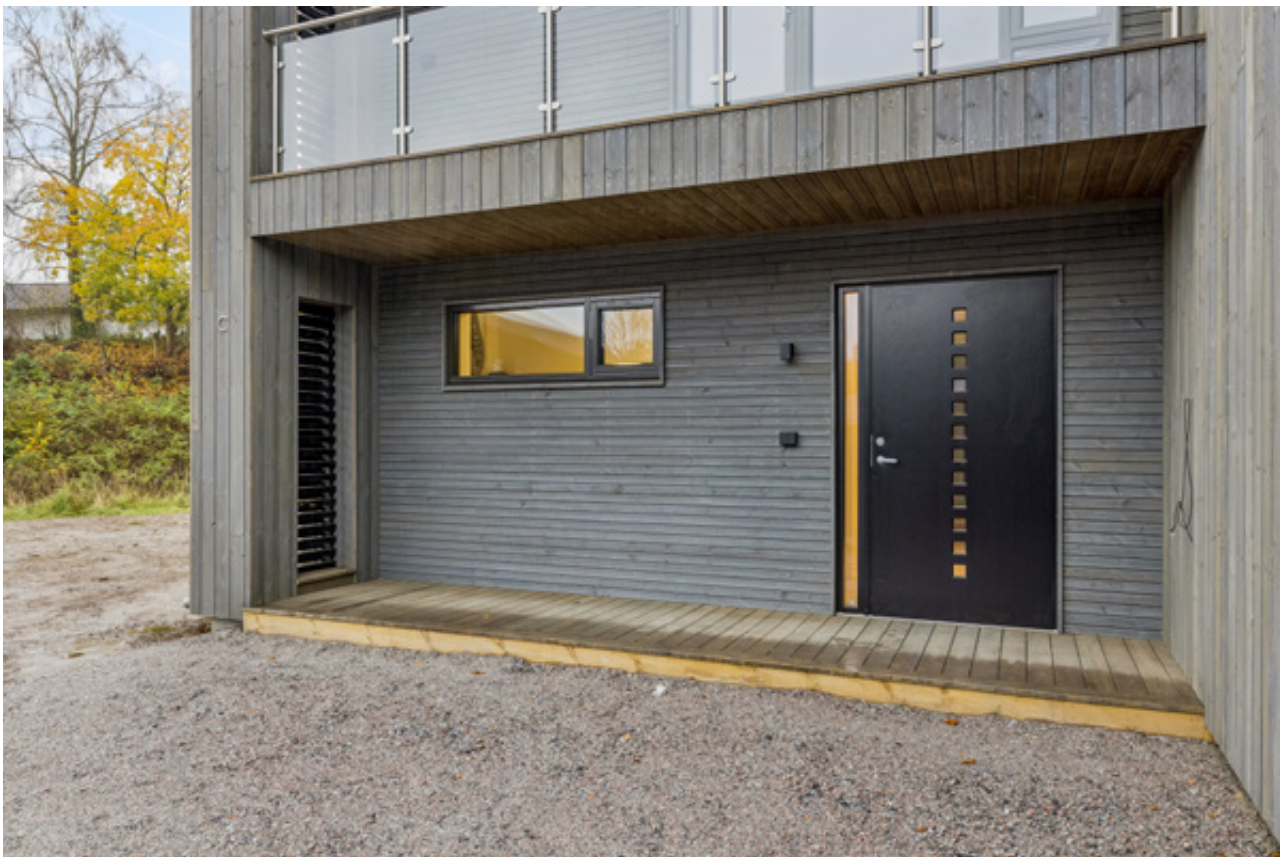
Hyggeilig overbygd inngangsparti. Gir et varmt og innbydende førsteinntrykk, samtidig som det beskytter mot vær og vind.
