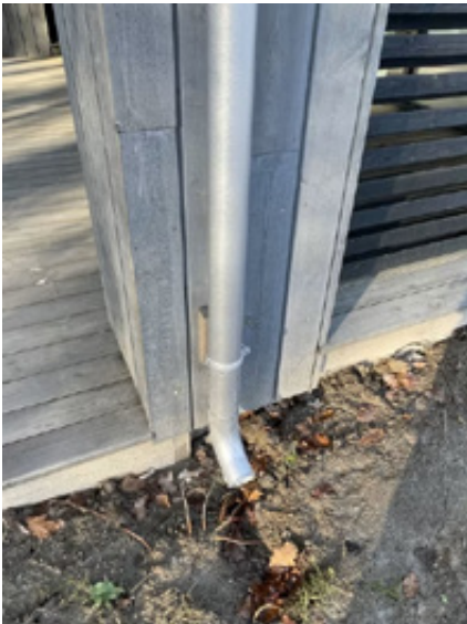
Det er montert utkast på nedløpsrør.
