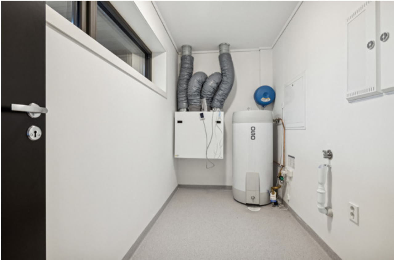
Vaskerom og tekniskrom
