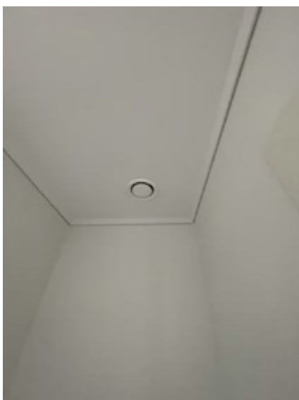
Mekanisk avtrekk i forbindelse med balansert ventilasjon.
