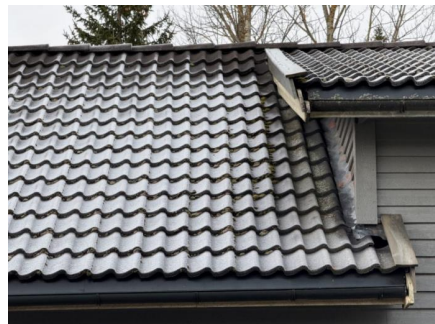
Noe mose på taktekking
