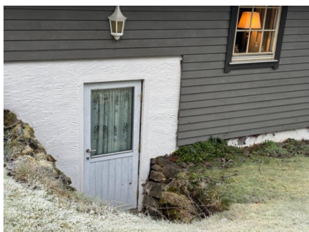
Terreng utenfor dør i grunnmur
