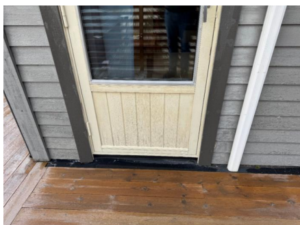
Slitte overflater i dør
