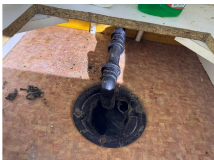
Ufagmessig tetting rundt rørgjennomføringer
