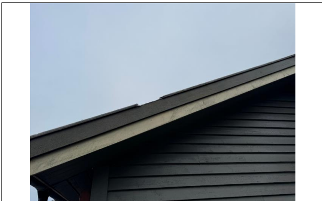
Råte i dekkbord på garasje
