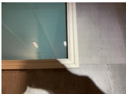
Vindu er plassert i våtsone, usikkert om dette er hensyntatt.
