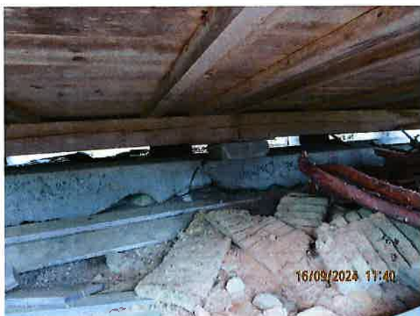
Fundament under midten på hytta.
