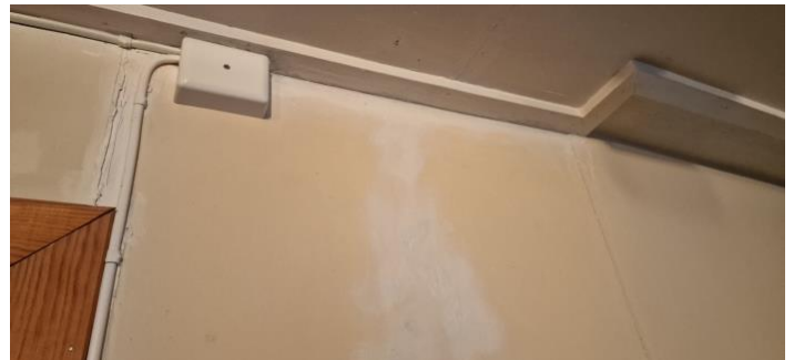
Eksempel på veggflate som er moden for overflatebehandling.
