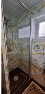
Overblikk av dusjnise med glassdør av nyere dato (ukjent årstall) og plastsluk.
