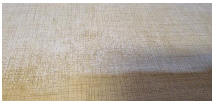
Litt merker/fargeforskjeller på eldre benkeplate.
