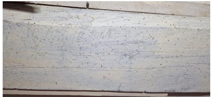
Motthull i trebjelke mellom kjeller og 1.etg.
