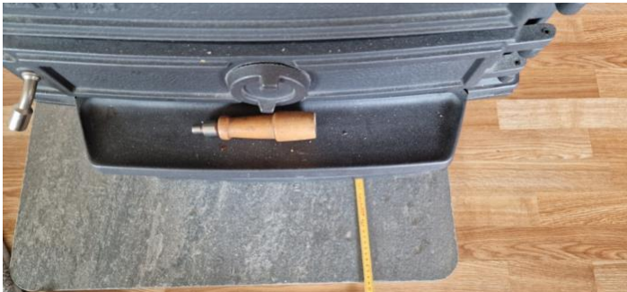
Ca. 19 cm med ildfast plate under ovn, denne bør lenger ut på gulvet.
